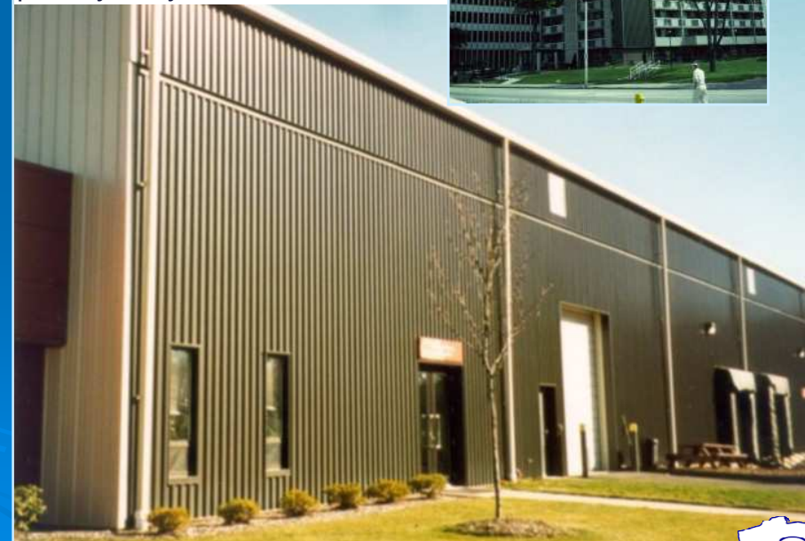
Brązowy kolektor na budynku przemysłowym, Connecticut, USA
